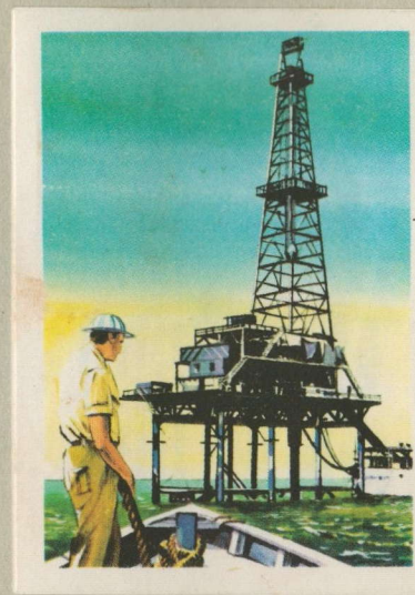
Derrick flottant - On édifie des derricks en pleine mer pour chercher dans les fonds marins le pétrole dont de 1964 à 1985, il faudra au monde libre quelque 40 milliards de tonnes.
